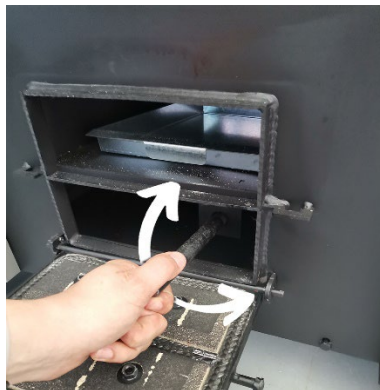
Figura 25. Curățarea tubulaturii cazanului
